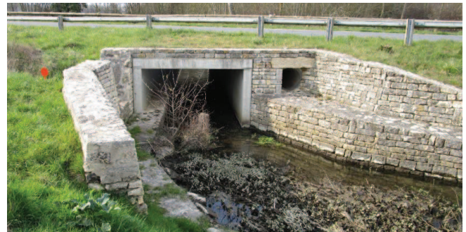
2 ponts adaptés à la continuité Loutre et Vison d'Europe par le CD 79 sur la D103, à Périgné
