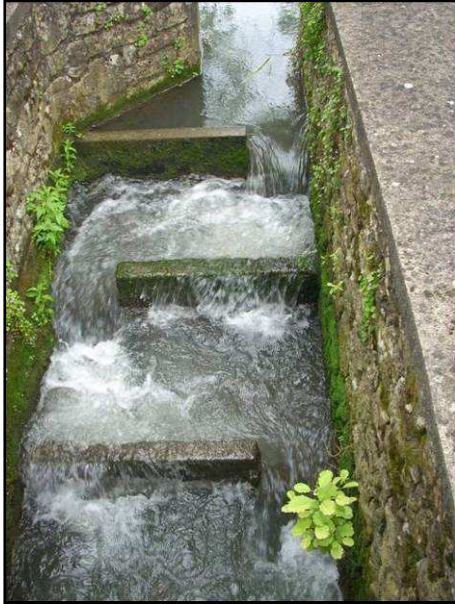
Passes à ralentisseurs sur la Boutonne (à gauche : passe du moulin de Brioux, à droite : barrage à clapet avec passe au moulin de l'Abbaye) (Sources : Biotopie, 2006)
