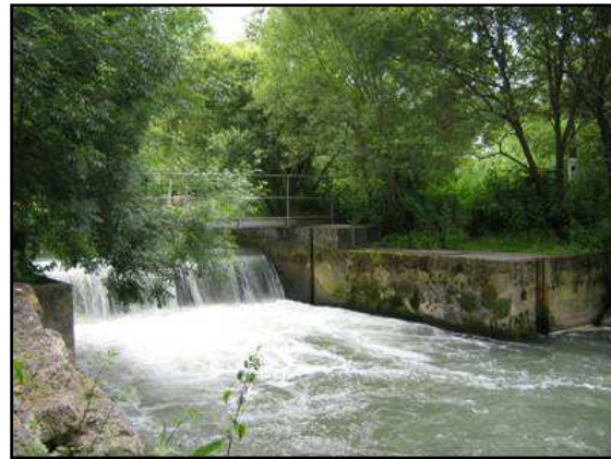
Passes à ralentisseurs sur la Boutonne (à gauche : passe du moulin de Brioux, à droite : barrage à clapet avec passe au moulin de l'Abbaye) (Sources : Biotopie, 2006)
