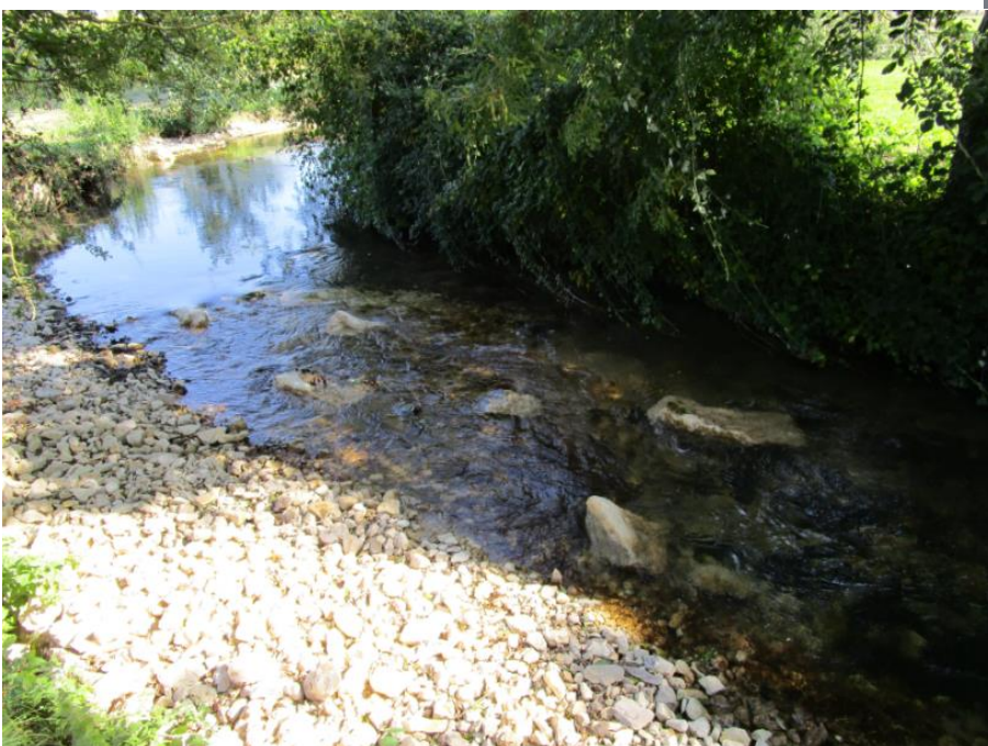
Travaux de restauration des habitats piscicoles par rechargement de blocs calcaire
